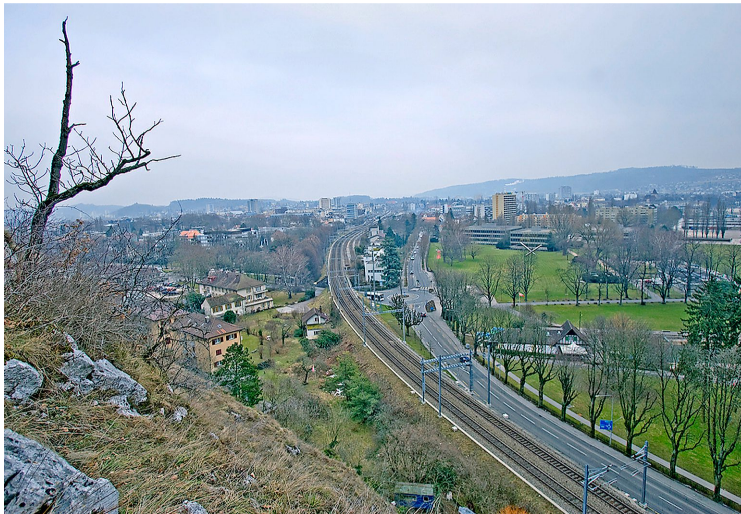
Zu dem im Berg verlaufenden Juratunnel könnte ein Anschluss unten in der Bieler Seevorstadt führen. Foto: Christian Fischer
