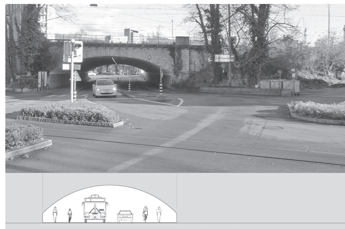
Unterführung Murtenstrasse heute. Hier soll der geplante Autobahnanschluss gebaut werden.
