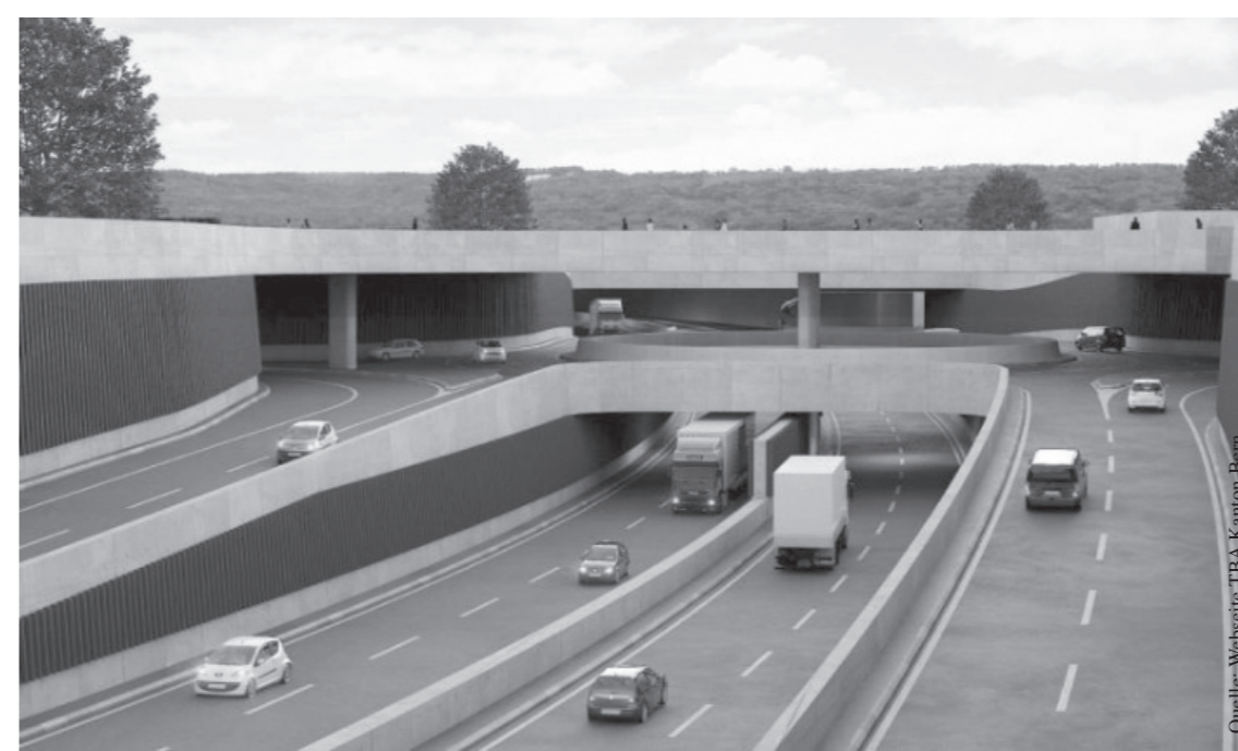
Autobahnanschluss Bahnhof: Blick vom Mühelfeld Richtung Bahnhof.
