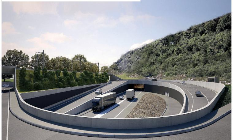
Pas de jonction au Strandboden! Juste à côté de la voie ferrée et du siège de Swatch Group la Confédération et le canton prévoient une tranchée ouverte de 11 mètres de profondeur, de 280 mètres de longueur et de 25 à 50 mètres de largeur
