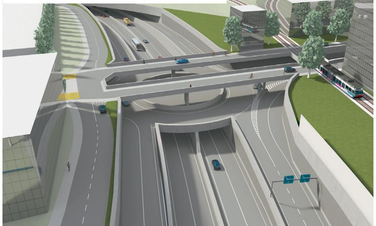
Pas de jonction autoroutière près de la gare! Juste à côté de la gare et du centre Coop la Confédération et le canton prévoient une tranchée ouverte sur trois étages (jusqu'à 18 mètres de profondeur), 275 mètres de longueur et 45 mètres de largeur: Dans le trou prévu la vieille ville de Nidau pourrait disparaître entièrement. (Sources visualisations: Office de ponts et chaussées Berne)
