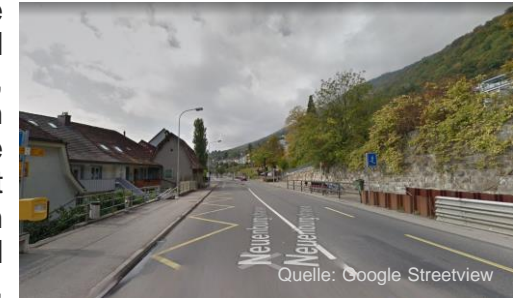
Neuenburgstrasse Abschnitt Mitte
