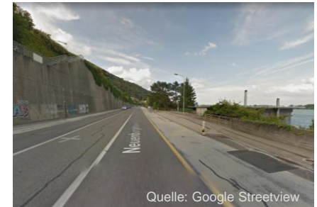
Neuenburgstrasse Abschnitt West
