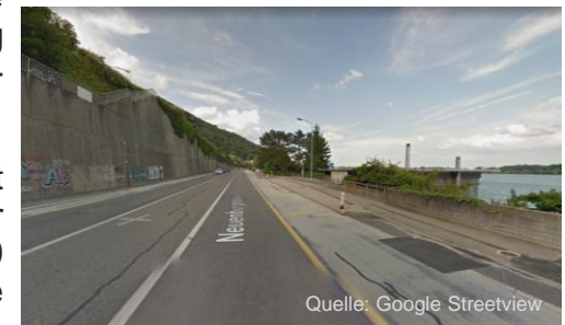
Neuenburgstrasse Abschnitt West
