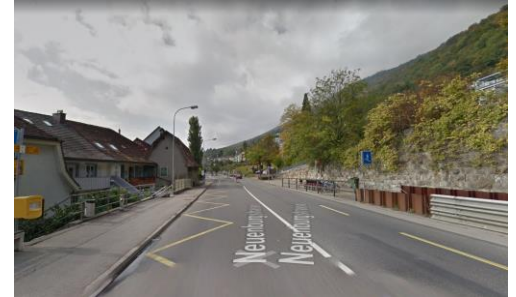
Neuenburgstrasse Abschnitt Mitte
