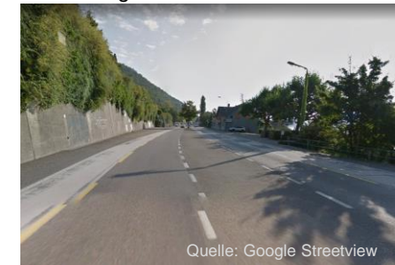
Neuenburgstrasse Abschnitt West
