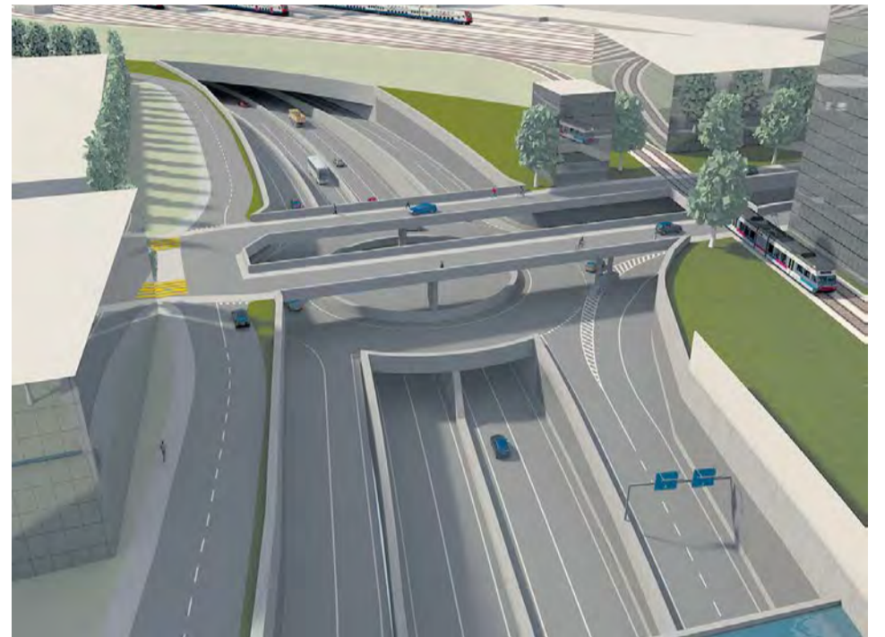
Der geplante Anschluss Bienne Centre: Zuunterst die Autobahn, auf der mittleren Ebene die Ein- und Ausfahrten, oben die alte Strasse. BILD: TIEFBAUAMT DES KANTONS BERN, MATHYS PARTNER
