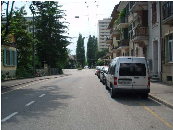
Bereits heute gibt es Handlungsbedarf: Querungsbeziehung über die Ländtestrasse (Foto vdw)
