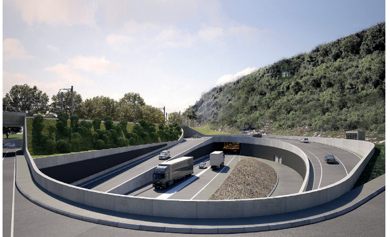
Kein Autobahnanschluss am Strandboden! Direkt neben der Bahnlinie und dem Hauptsitz der Swatch Group planen Bund und Kanton einen offenen, bis zu 11 Meter tiefen Schlitz von 280 Metern Länge. 25 bis 50 Metern Breite
